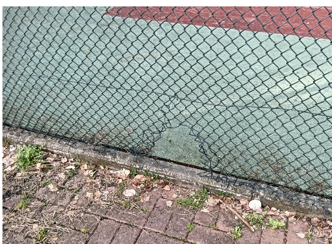
Widok uszkodzeń ogrodzenia z siatki
