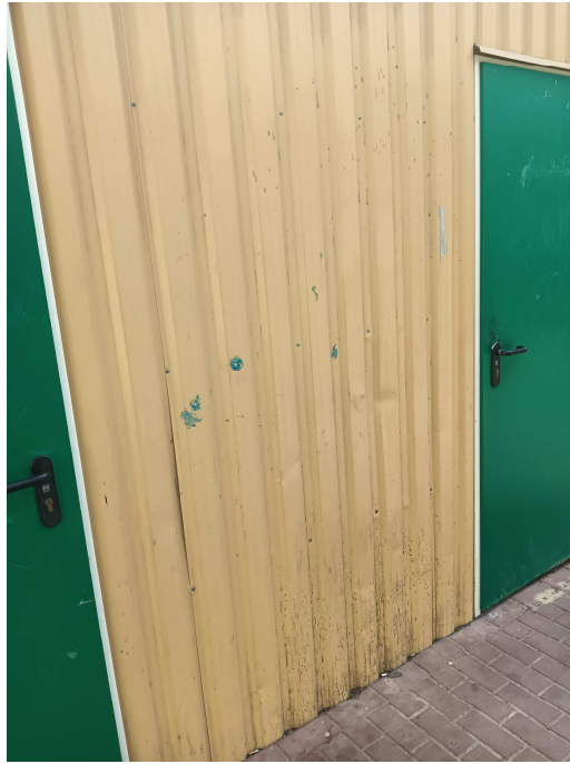
Widok uszkodzeń blachy elewacyjnej
