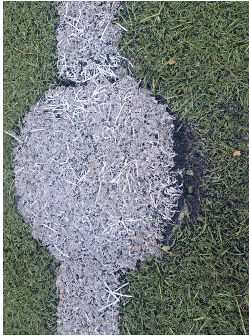
Widok odklejenia środka boiska do piłki nożnej
