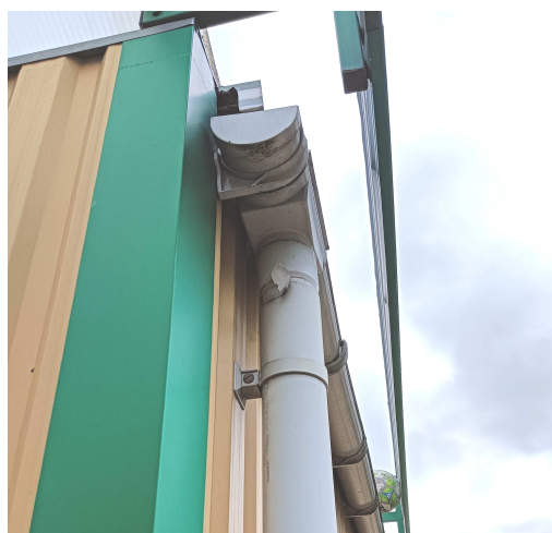
Widok zniszczeń rur spustowych
