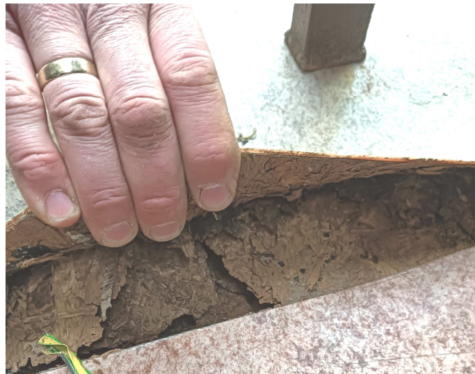
Widok zniszczonej podłogi w pom. łazienki
